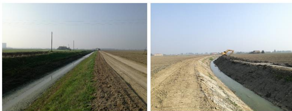
Sopralzi e adeguamenti arginali
