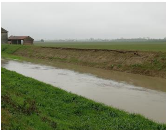
Frana della sponda
