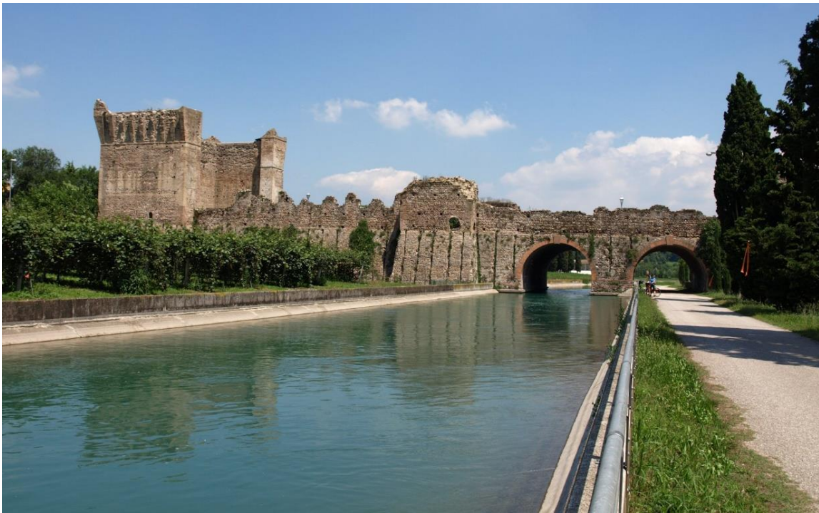
Ponte-diga Visconteo lungo il Canale Virgilio a Borghetto (Consorzio di Bonifica Garda Chiese).
