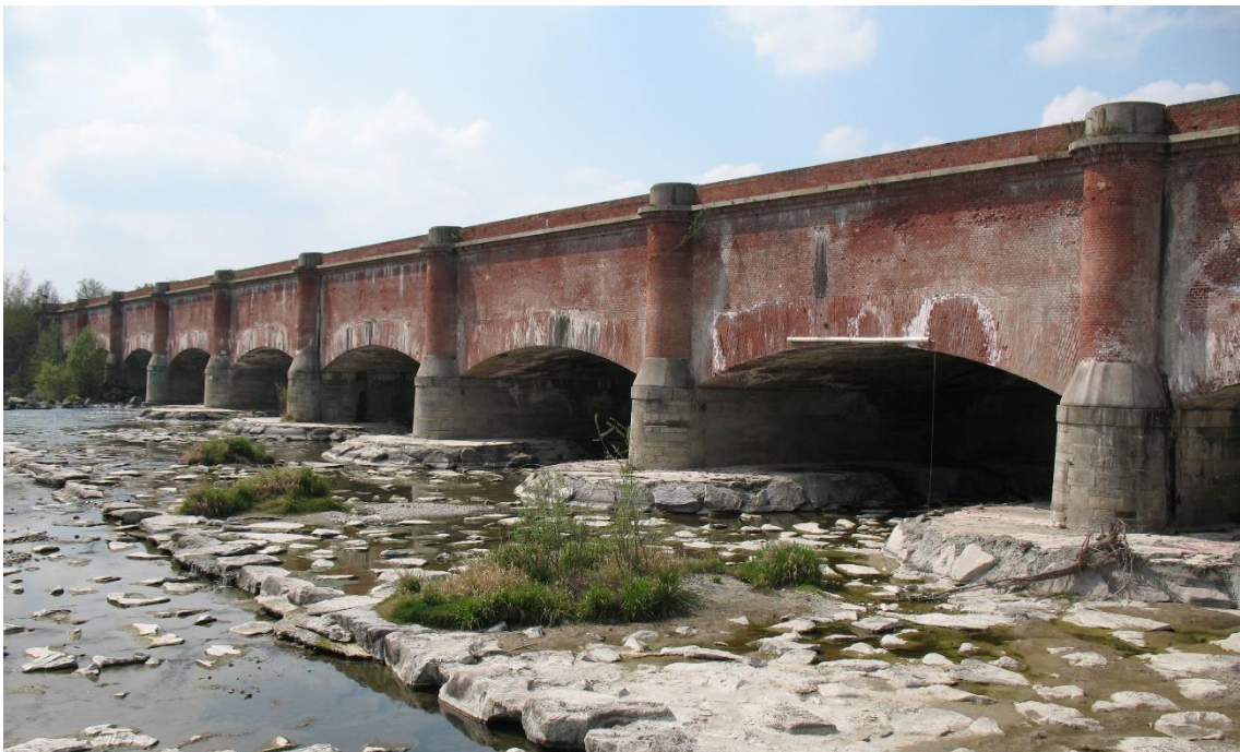
Ponte canale del Canale Cavour sul fiume Sesia (Consorzio di Bonifica Ovest Sesia – Canali Cavour).
