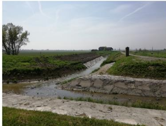
ripresa di frana con massi
