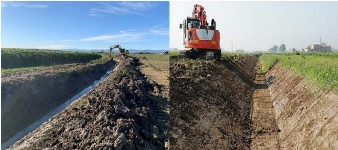
Esempi di risezionamento di canali con deposito del sedimento
